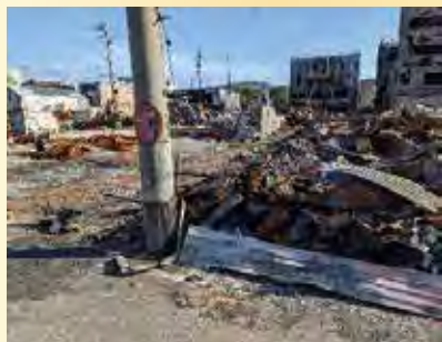
■ 火災時に機能しなかった消火栓と河川
