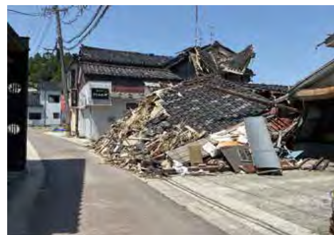
倒壊現場（珠洲市）
