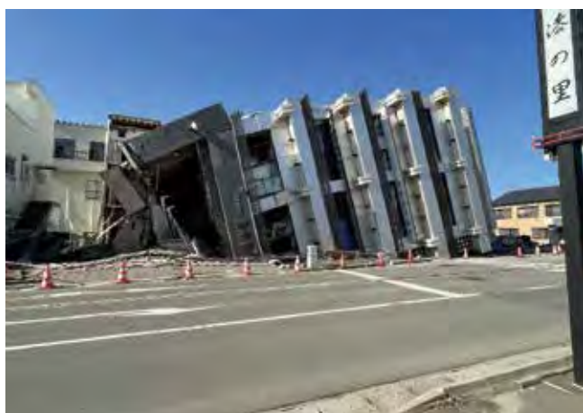
横倒しになった7階建てのビル（輪島市）
