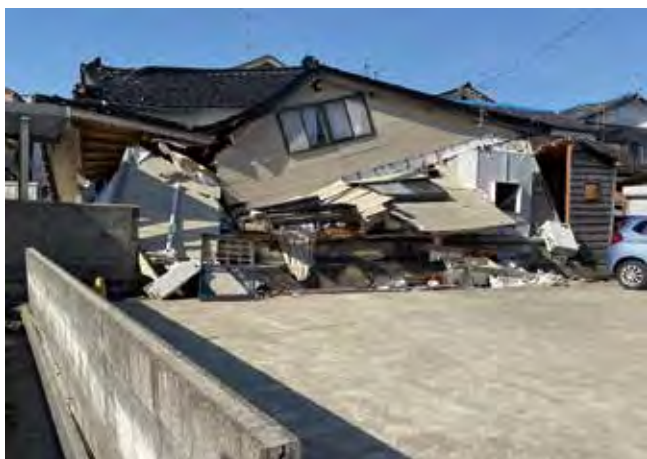
倒壊現場（輪島市）
