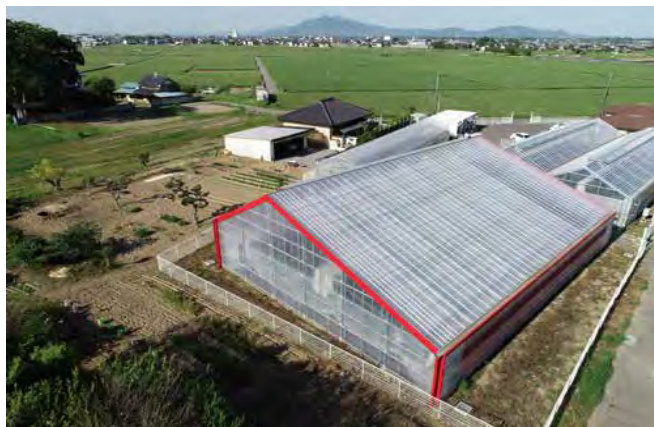
■ TODA 農房合同会社が運営する「TODA 農房」
