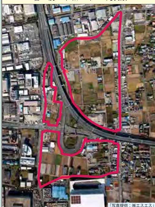
着工前：令和3年11月撮影
