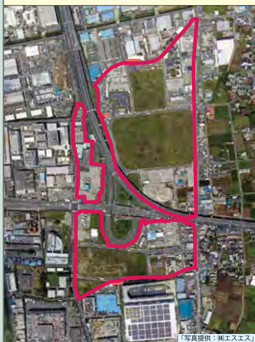
施工中：令和6年8月出来高99.9%
