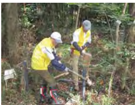
ロープ柵補修作業
